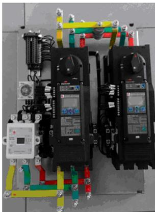
星三角控制单元外形图（内接法）
