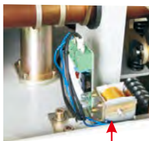
底盘车闭锁电磁铁
