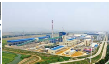
台州临港热电有限公司 (电力生产控制设备)
